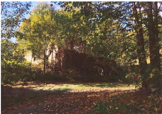
Bâtiment en ruine
